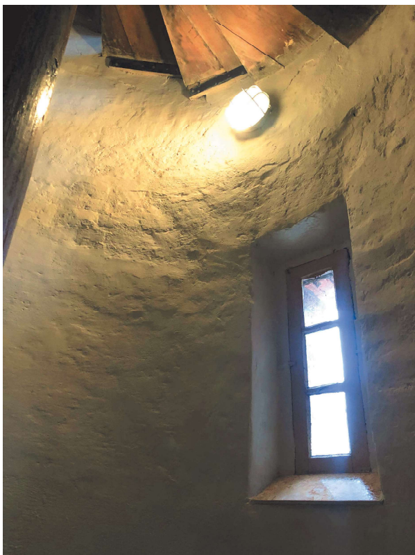
nierówności tynku klatek schodowych w wieżyczkach
