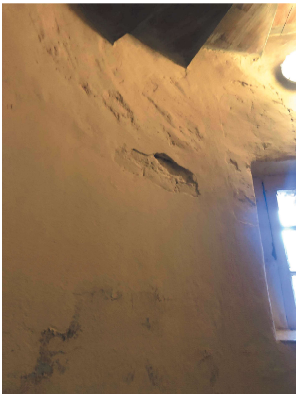
Ubytki i nierówności w tynku wieżyczek mieszczących klatki schodowe
