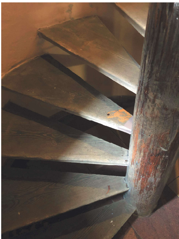
zniszczone schody kręte w wieżyczkach ( schody na chór )
