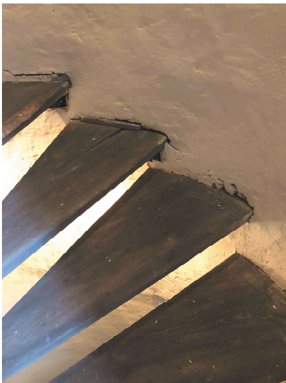
nierówności tynku klatek schodowych w wieżyczkach
