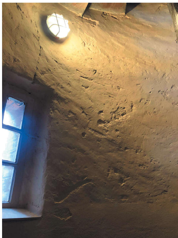
Ubytki i nierówności w tynku wieżyczek mieszczących klatki schodowe
